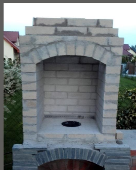
fot. 15. Komora grilla i wędzarni z cegły szamotowej.
