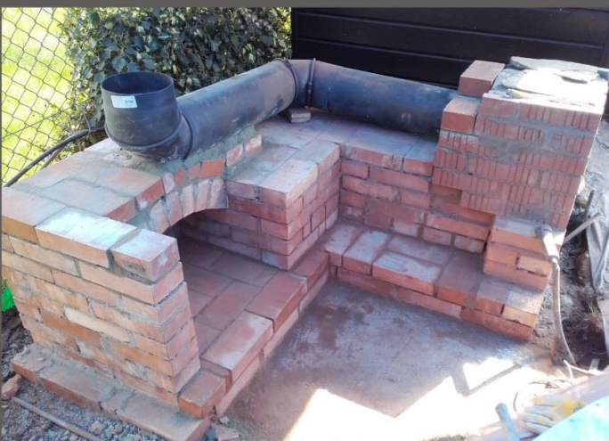
fot.9 Korpus grillo-wędzarni wykonany z pełnej cegły
