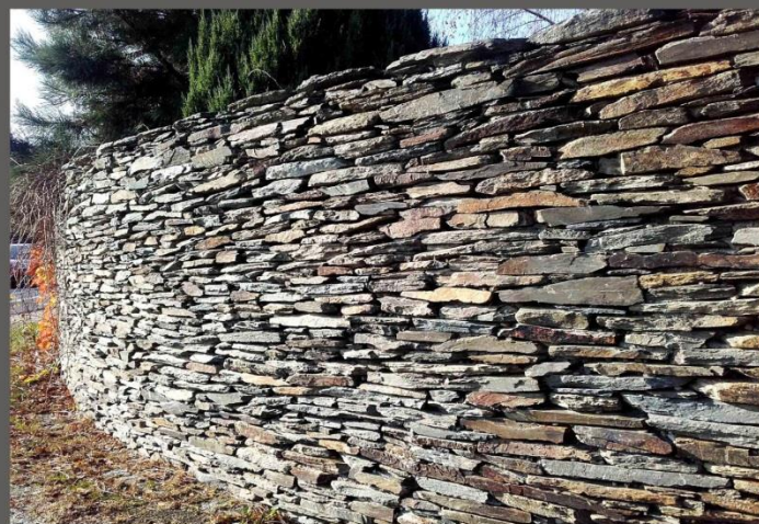
fot. 17. Mur z łupka szarogłazowego
