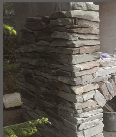
fot. 12. Narożnik oklejony kamieniem
