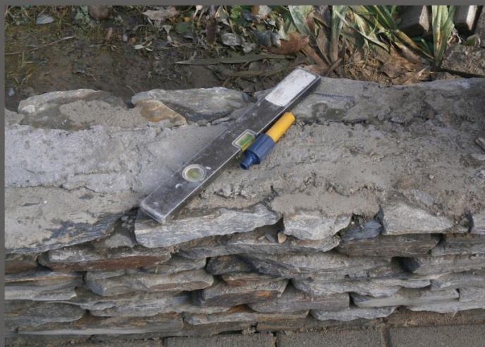
fot.6 Budowa muru
