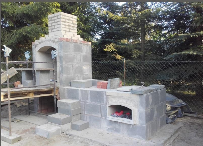
fot.8 Korpus grillo-wędzarni wykonany z bloczka betonowego i cegły szmotowej.
