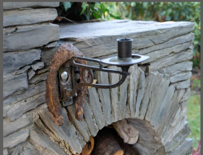
fot. 5 Łuk z kamienia surowego drobnego
