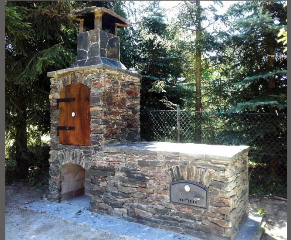
fot. 3 Grillo-wędzarnia oklejona łupkiem jednostronnie ciętym oraz łupkiem elewacyjnym
