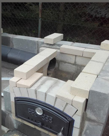
fot. 13. Palenisko z cegły szamotowej.
