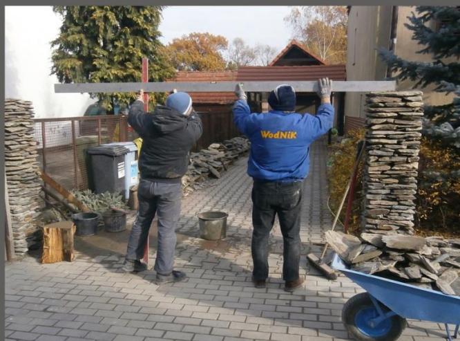
fot.7 Budowa ogrodzenia
