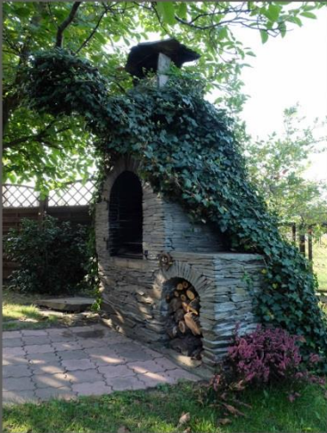
fot. 1 Grillo-wędzarnia wykonana z kamienia surowego drobnego
