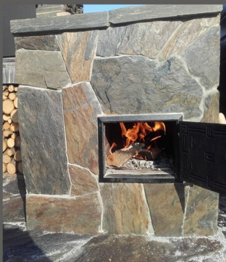
fot. 10. Kamień elewacyjny łupany
