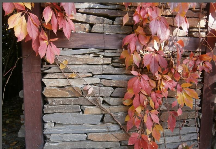
fot. 16. Mur z kamienia fasadowego
