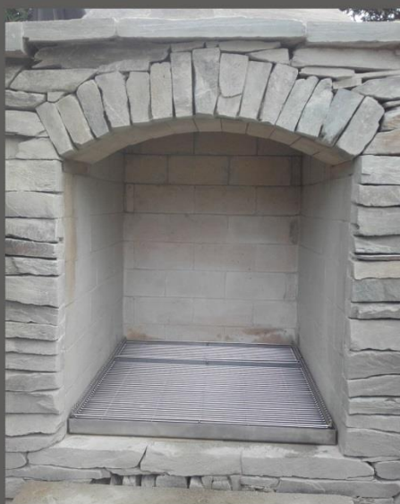
fot. 14. Palenisko grilla z cegły szamotowej.
