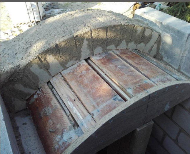
fot. 4 Murowanie łuku
